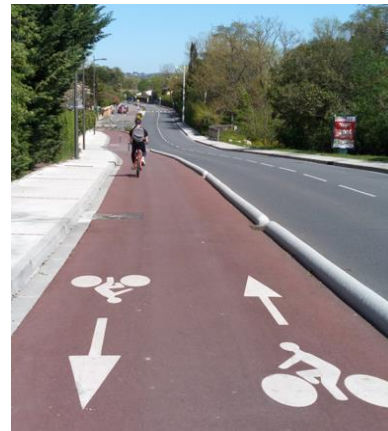
Piste cyclable bidirectionnelle sur chaussée avec séparateur physique. Pictos vélo et couleur de chaussée différente
