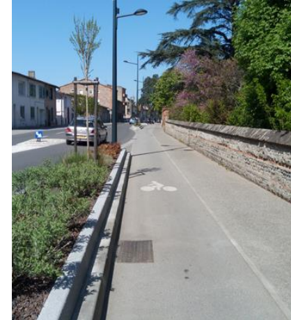
Piste cyclable unidirectionnelle sur trottoir. Picto vélo et séparation avec piétons (revêtement différent)
