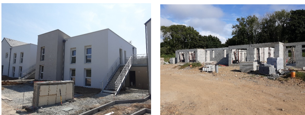
Trébeurden : Opération de Terres d'Armor Habitat et projet Equity
