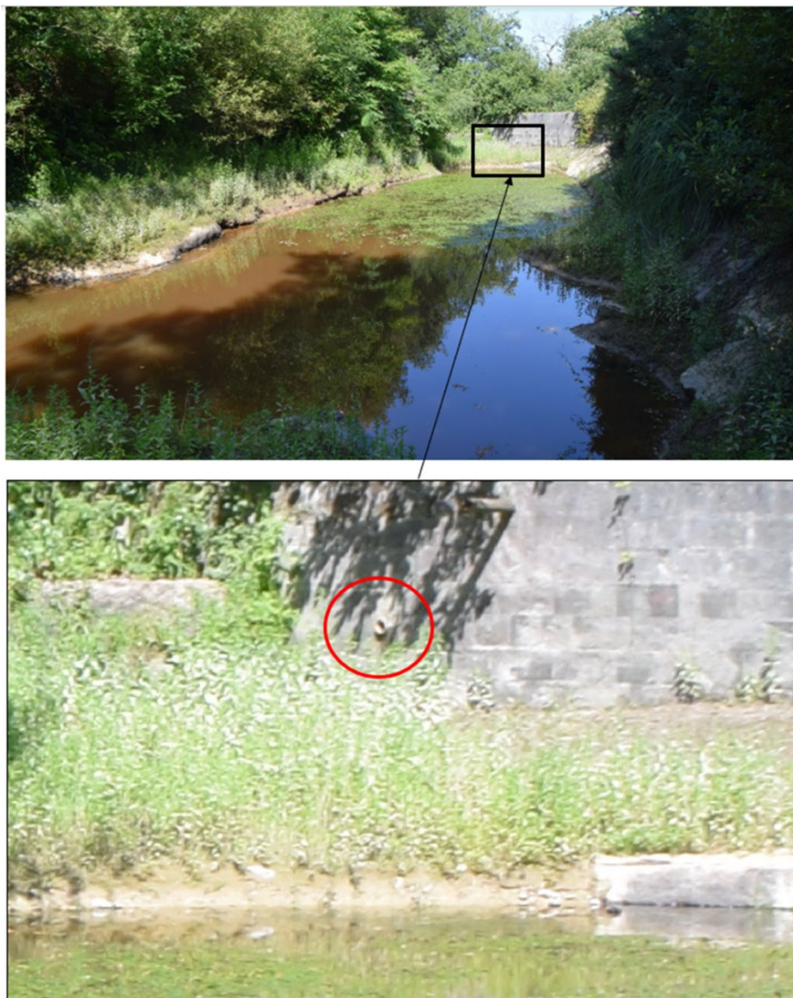
Photographie du bassin B3 et du tuyau de rejet (photographie du 20 juillet 2021)
