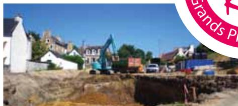
Dans le cadre du schéma d'assainissement des eaux pluviales, un bassin de rétention a été réalisé rue Goas an Abat.
