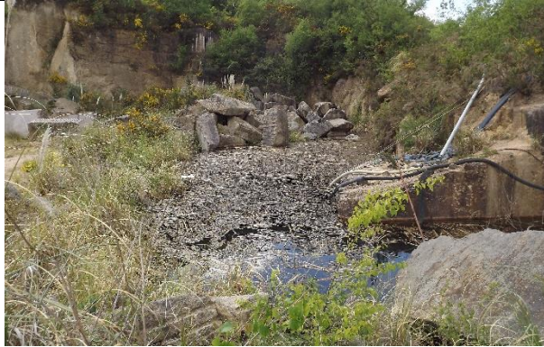
Bassin de carrière
