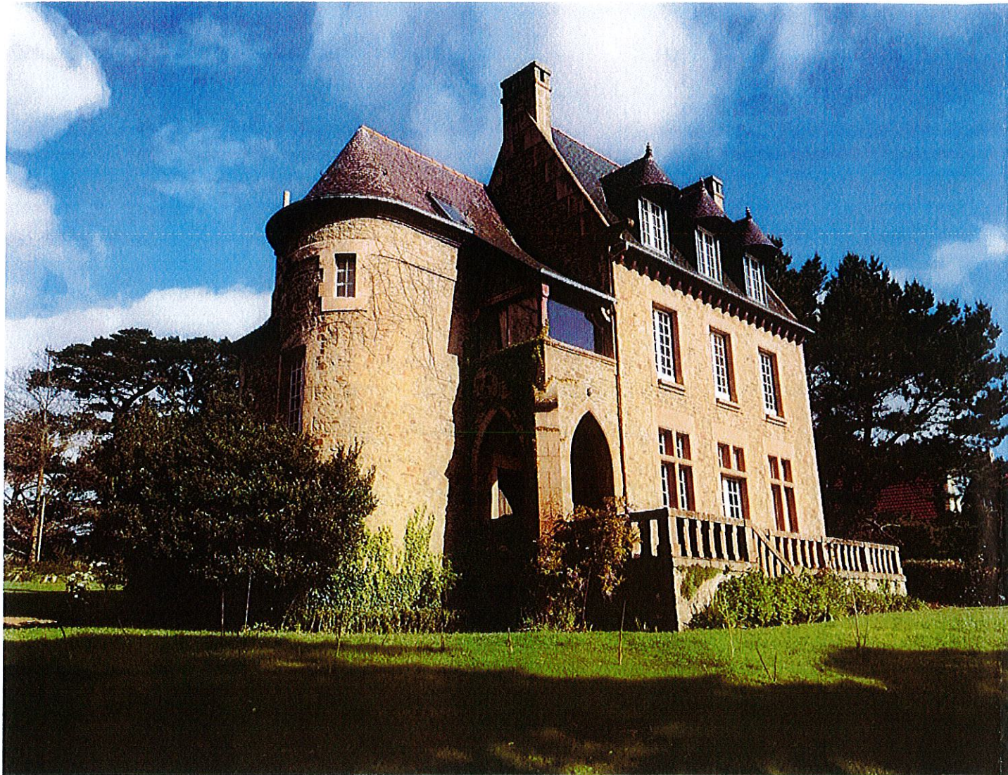
EXISTANT AVANT-TRAVAUX : VUE DEPUIS LE JARDIN CÔTÉ SUD/EST, LE LONG DU SENTIER DES DOUANIERS
